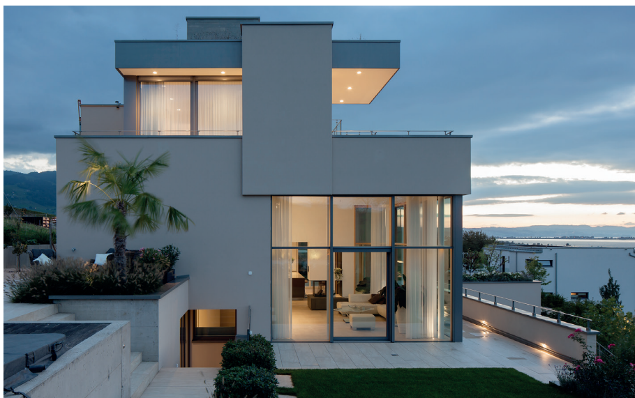
■ Die Anlage besteht aus einer leistungsfähigen Industriesteuerung, die in der Lage ist, Prozesse der Heimautomation effizient zu regeln.
